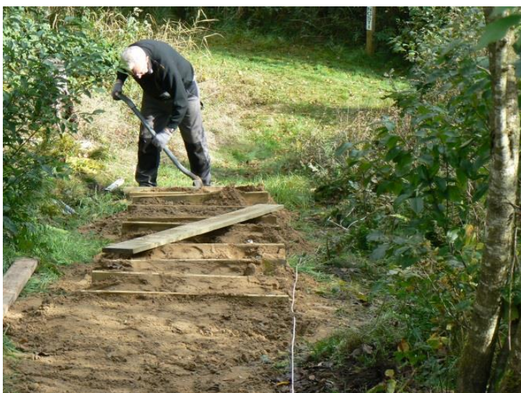
Erik er i gang med trappen
